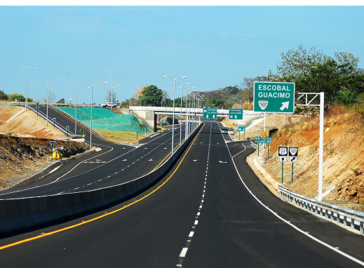
Autopista San José Caldera. Costa Rica.
