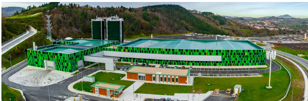
Construcción y puesta en marcha de la fase 2 del Complejo Medioambiental. Guipúzcoa (País Vasco).
