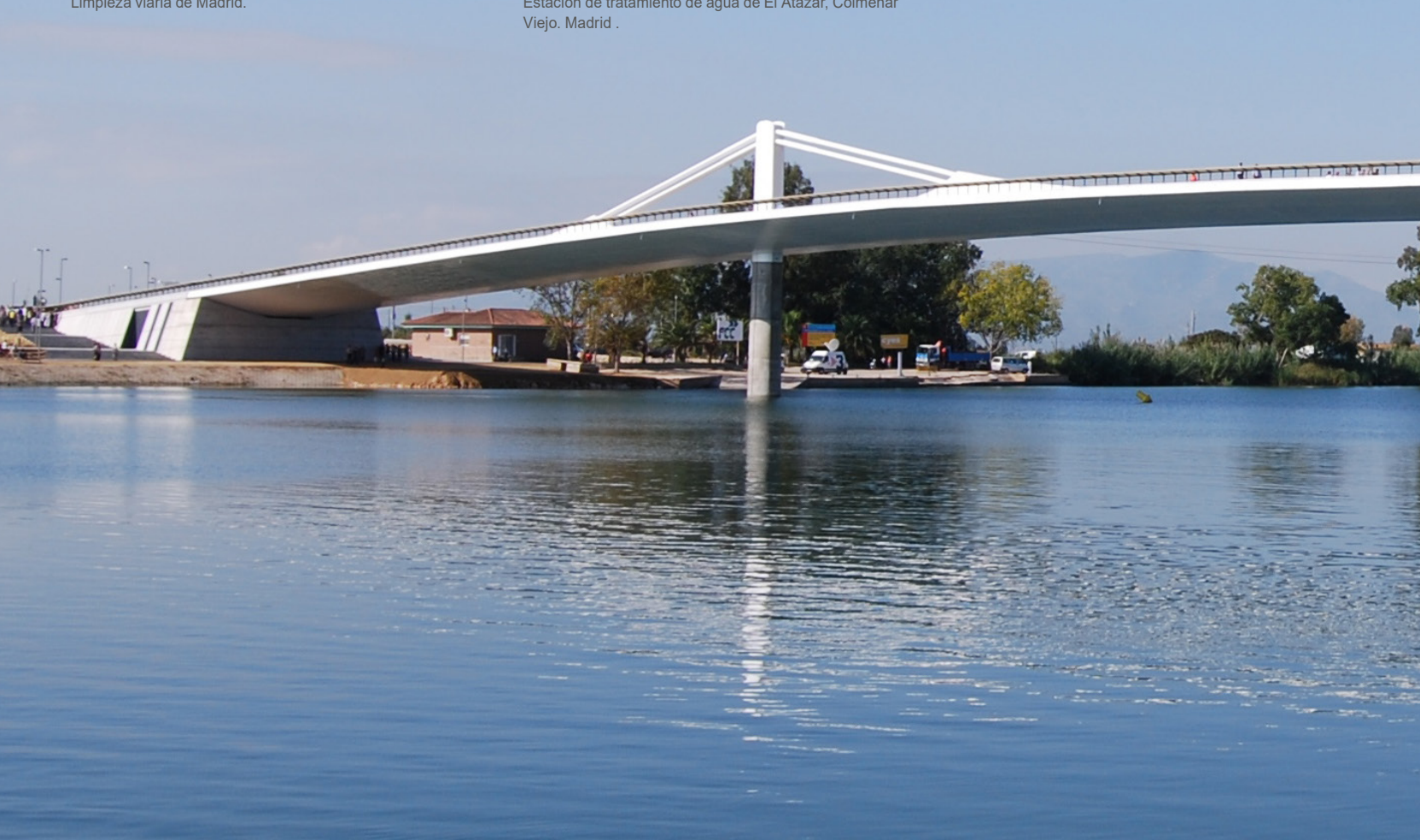
Puente sobre el delta del Ebro. Tarragona.
