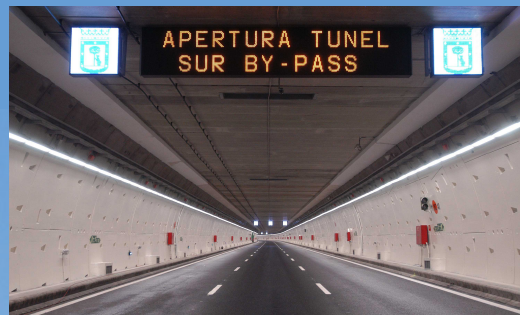
Túnel By-Pass Sur M-30. Madrid.
