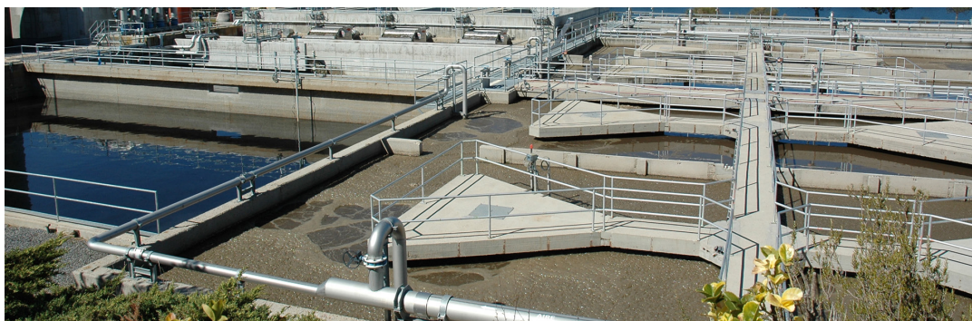
Depuradora en Ávila.
