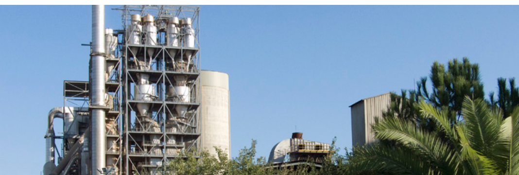
Fábrica de cemento Alcalá de Guadaíra (Sevilla).
