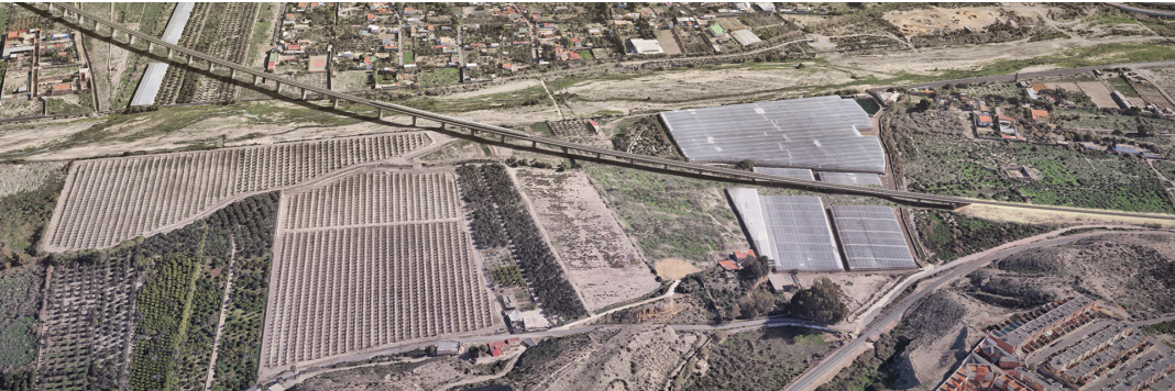
Construcción de la plataforma del Corredor Mediterráneo de Alta Velocidad Murcia-Almería, tramo: Nijar-Río Andarax.
