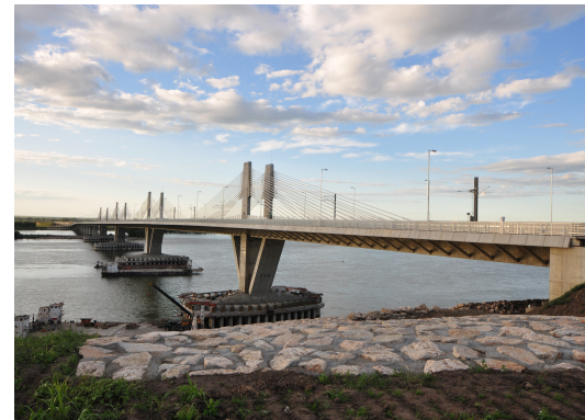
Puente de Vidin-Calafat situado en la frontera entre Bulgaria y Rumanía.
